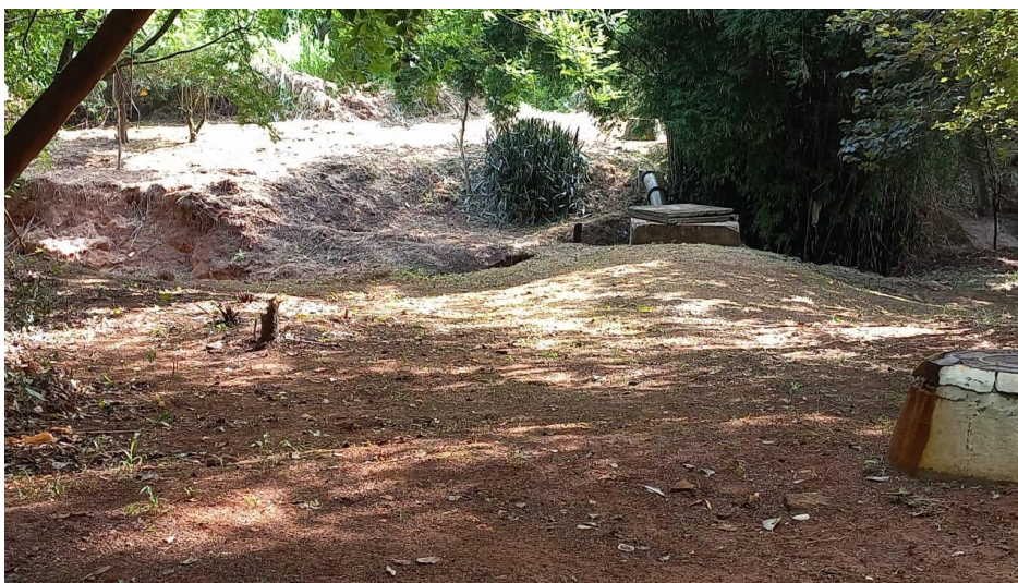
Foto 6: Vista da Travessia do Emissário de Esgoto sobre o Córrego José Venâncio
