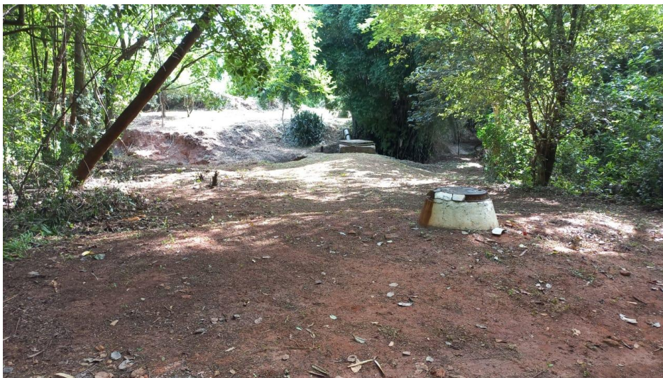
Foto 5: Vista da Travessia do Emissário de Esgoto sobre o Córrego José Venâncio
