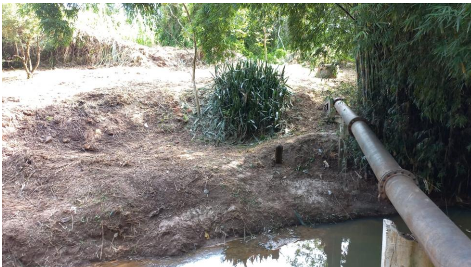
Foto 11: Vista da Travessia do Emissário de Esgoto sobre o Córrego José Venâncio Dias
