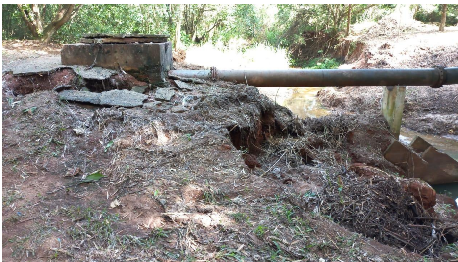
Foto 12: Vista da Travessia do Emissário de Esgoto e a margem esquerda do Córrego José Venâncio Dias
