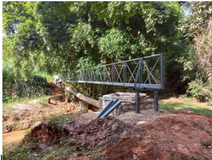
Foto 7: Vista da Travessia do Emissário de Esgoto sobre o Córrego José Venâncio
