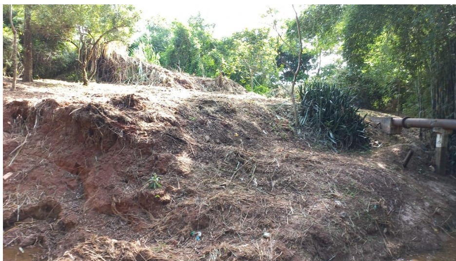
Foto 8: Vista do Emissário de Esgoto e a margem esquerda do Córrego José Venâncio Dias
