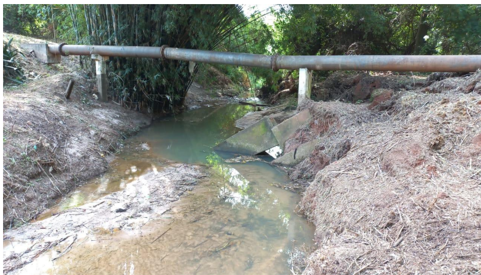
Foto 1: Córrego José Venâncio Dias com a Travessia do Emissário de Esgoto
