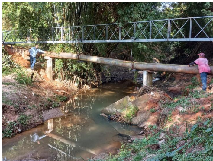
Foto 2: Córrego José Venâncio Dias com a Travessia do Emissário de Esgoto
