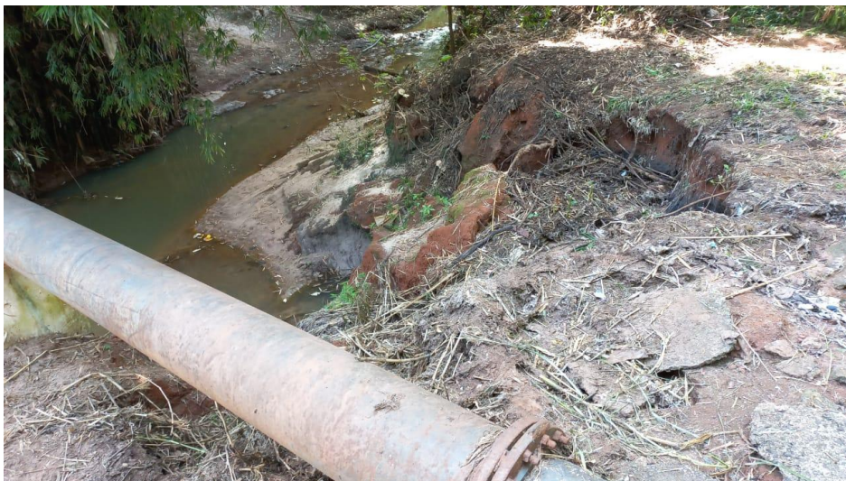
Foto 4: Córrego José Venâncio Dias com a Travessia do Emissário de Esgoto
