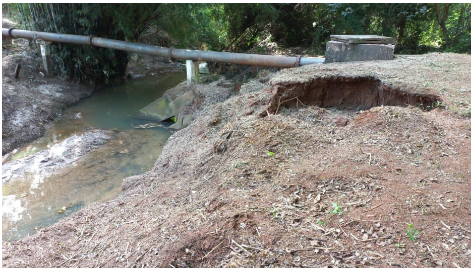
Foto 13: Vista da Travessia do Emissário de Esgoto sobre o Córrego José Venâncio Dias
