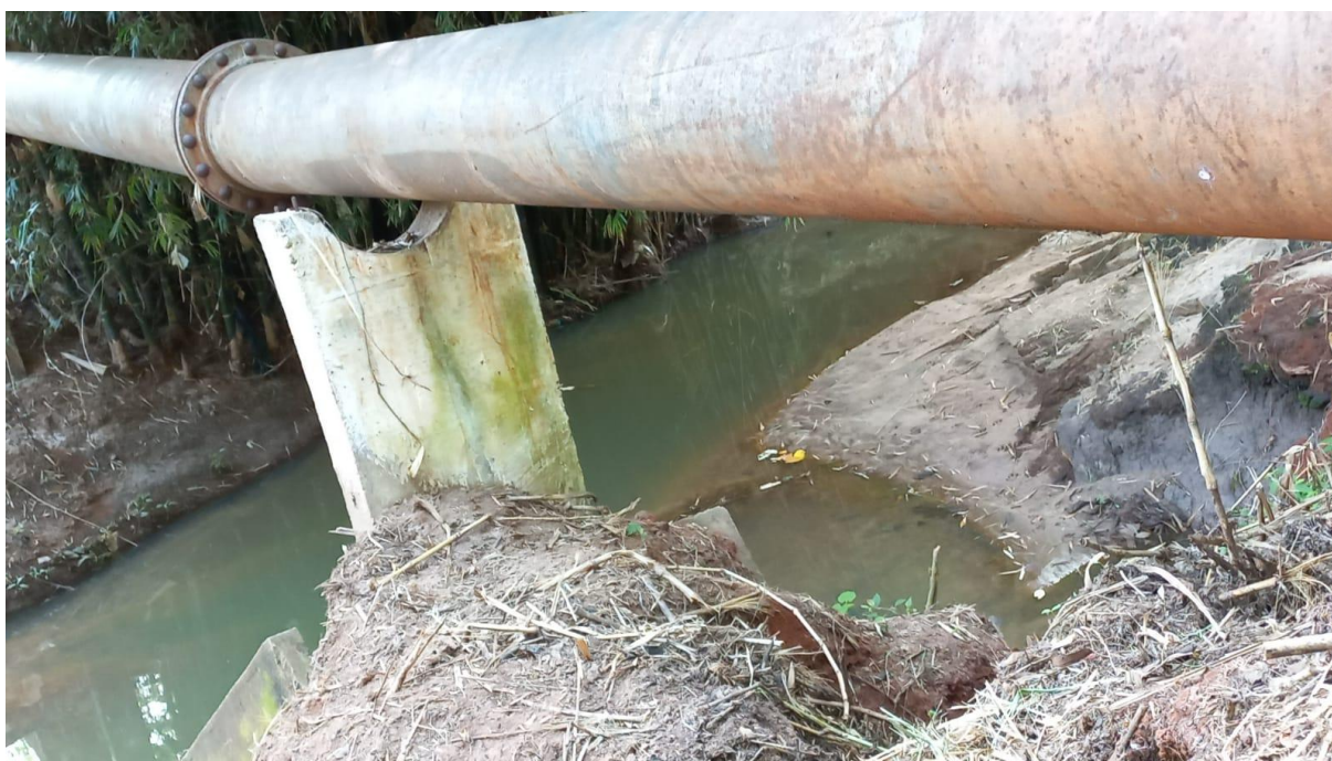
Foto 10: Vista da Travessia do Emissário de Esgoto sobre o Córrego José Venâncio Dias
