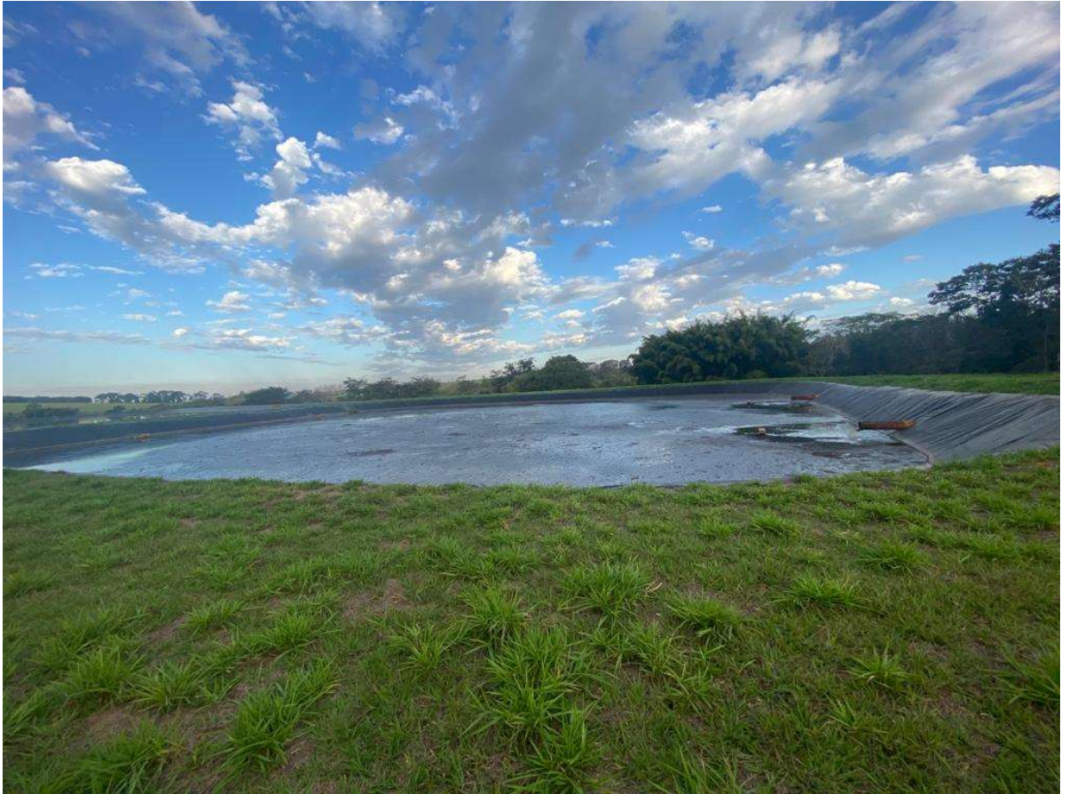
VISTA DA ENTRADA LAGOA ANAEROBICA
