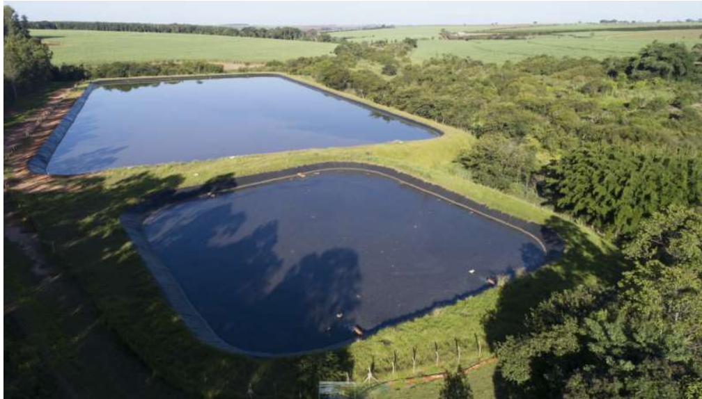
VISTA GERAL DAS LAGOAS EXISTENTES
