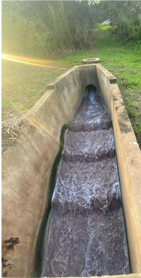
ESCADA DE AERAÇÃO EXISTENTE
