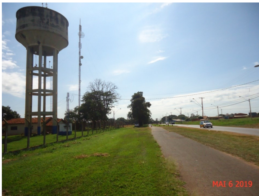
Figura 3 - Vista geral de trecho gramado paralela à Rodovia Renê Vaz de Almeida área a ser executada a substituição da adutora principal.
