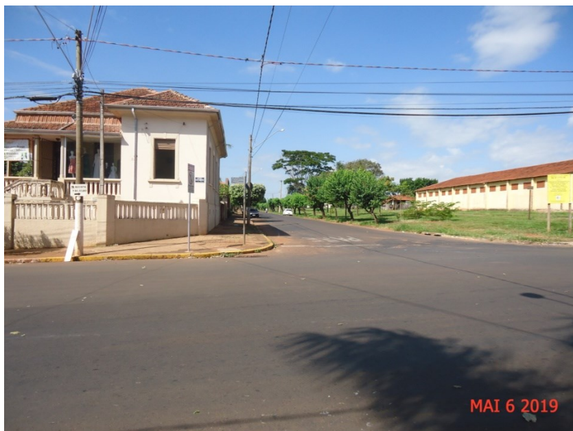
Figura 8 - Vista da Av. Pio de Mello Nogueira, no leito carroçável será substituída a adutora de Dn 200 m e pela calçada de passeio, lado esquerdo será executada a rede de distribuição de água potável com Dn 50 mm, conforme projeto.
