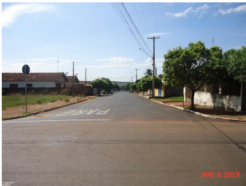
Figura 9 - Vista da Rua Henrique Paro, no leito carroçável será substituída a adutora de Dn 200 mm e pelas calçadas de passeio serão executadas as redes de distribuição de água potável com Dn 50 mm, conforme projeto.
