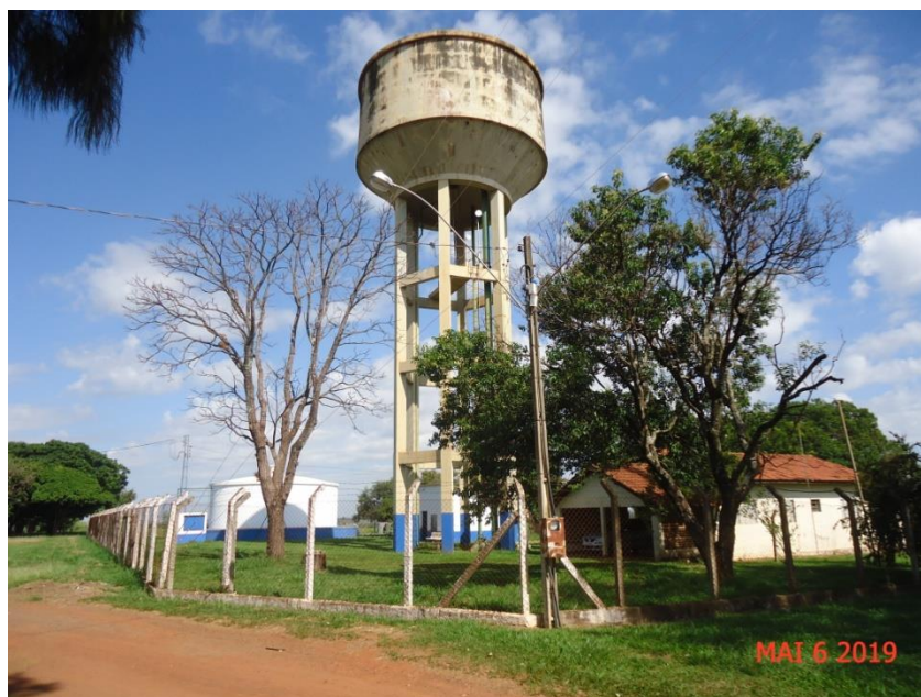
Figura 1 - Vista geral do reservatório elevado de volume 600 m 3 e do reservatório apoiado ao fundo de volume 400 m 3 , existentes na Rodovia Renê Vaz de Almeida, Km 01.
