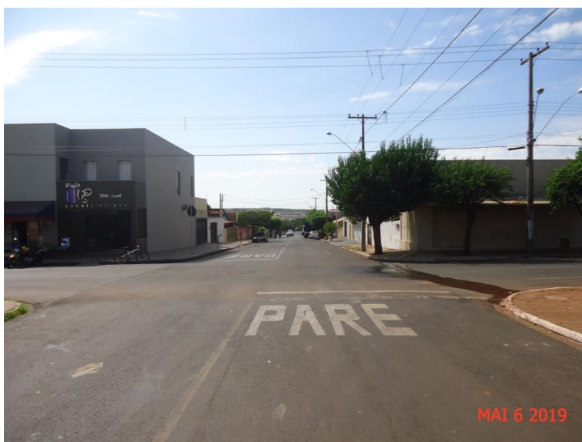
Figura 10 - Continuidade da Rua Henrique Paro, local de substituição da adutora de Dn 200 mm e execução de rede de distribuição de água potável em ambas as calçadas de passeio.
