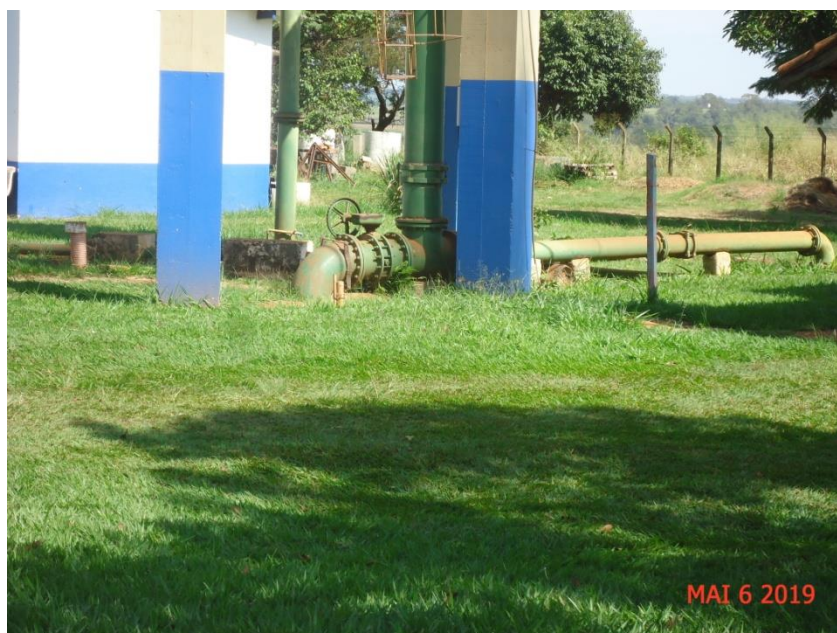
Figura 2 - Início da substituição da adutora principal de 350 mm, abaixo do reservatório elevado.
