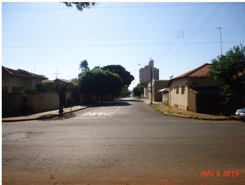
Figura 5 - Vista da Rua Salvador Campagnon, substituição da rede existente de FoFo - “ferro fundido”, para rede de abastecimento de água potável de PVC/PBA de Dn 50 mm.
