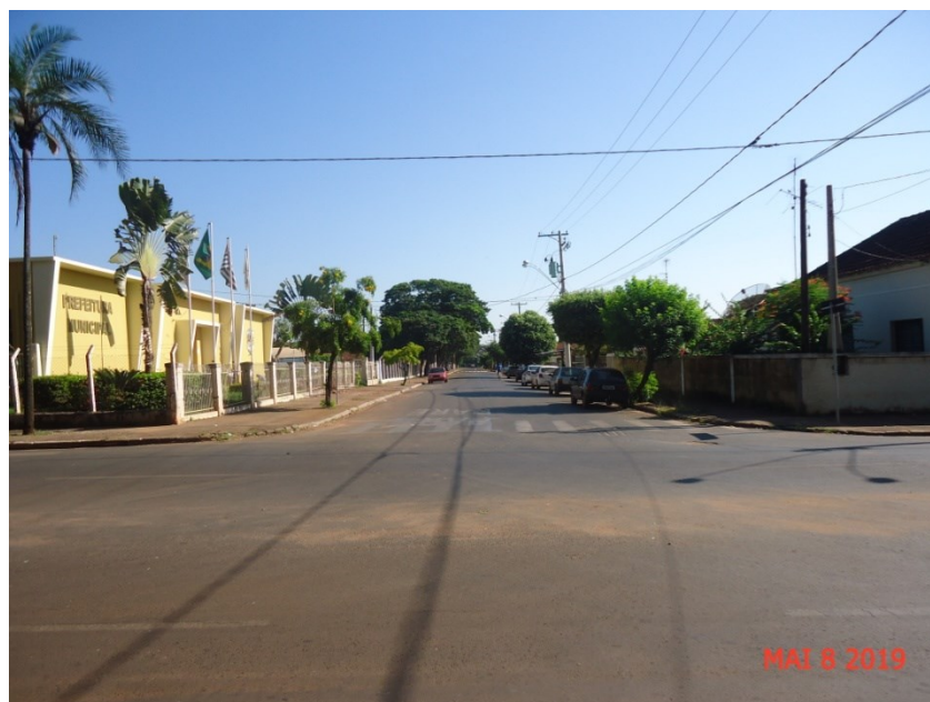
Figura 2 - Vista da Rua Antônio Paulo de Miranda, substituição da rede existente de FoFo - "ferro fundido", para rede de abastecimento de água potável de PVC/PBA de Dn (100 e 75) mm.
