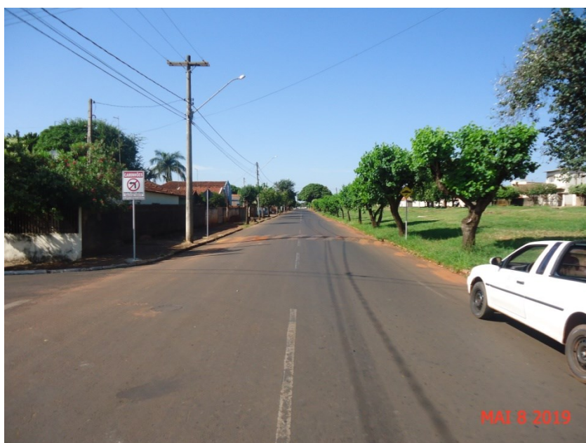
Figura 10 - Vista da Avenida Pio de Mello Nogueira, substituição da rede existente de FoFo - “ferro fundido”, para adutora secundária de abastecimento de água potável de Dn 150 mm executada em DeFoFo (diâmetro equivalente ao ferro fundido) e execução de rede de abastecimento de água potável de Dn 50 mm, pela calçada de passeio.
