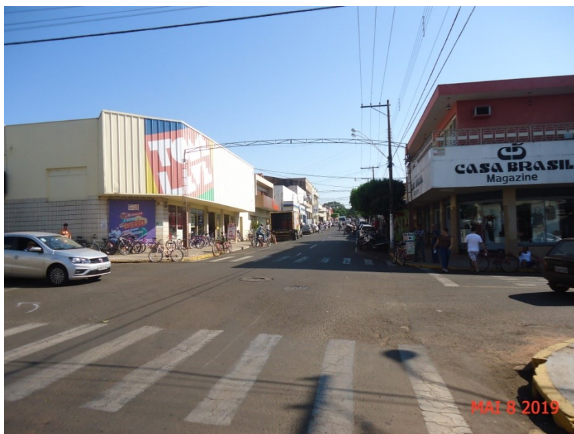
Figura 13 - Vista da Rua 7 de Setembro, substituição da rede existente de FoFo - “ferro fundido”, para rede de abastecimento de água potável de Dn 50 mm executada em PVC/PBA, trecho entre as Rua Alfredo Simões de Campos Filho e Av. Rui Barbosa.
