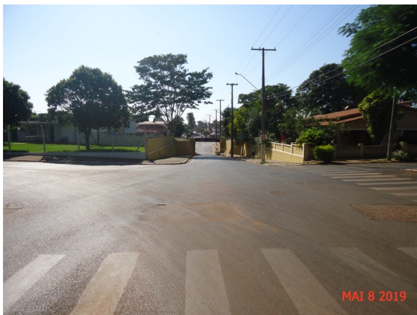
Figura 9 - Vista da Avenida Rui Barbosa, substituição da rede existente, adutora secundária de FoFo - “ferro fundido”, para adutora secundária de abastecimento de água potável executada com tubos DeFoFo (diâmetro equivalente ao ferro fundido) de Dn 200 mm.
