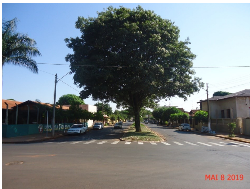
Figura 14 - Vista da Avenida Ângelo Martins Tristão, substituição da rede existente de FoFo - “ferro fundido”, para adutora secundária de abastecimento de água potável de Dn 200 mm executada em DeFoFo (diâmetro equivalente ao ferro fundido) e execução de rede de abastecimento de água potável de Dn 50 mm, em ambas as calçadas de passeio.
