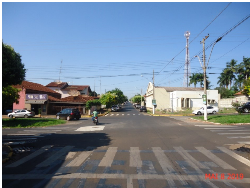
Figura 17 - Vista da Rua 13 de Maio, substituição da rede existente executada em C.A. - “cimento amianto”, para rede de abastecimento de água potável executada com tubo PVC/PBA de Dn 50 mm, trecho entre a Av. Dr. Manoel Palomino Fernandes e Rua Antônio Guarnieri.
