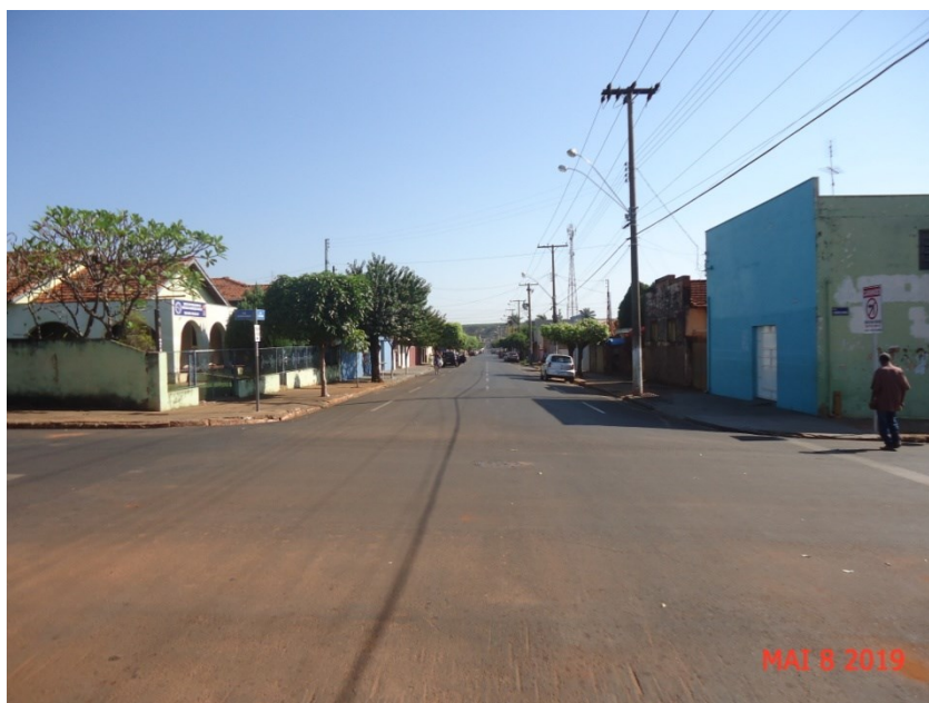
Figura 12 - Vista da Rua 7 de Setembro, substituição da rede existente de FoFo - “ferro fundido”, para rede de abastecimento de água potável de Dn 50 mm executada em PVC/PBA, trecho entre a Rua Henrique Paro e Rua Antônio Guarnieri.
