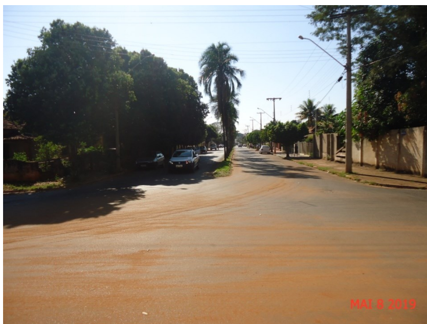
Figura 6 - Vista da Avenida Rui Barbosa, substituição da rede existente de FoFo - “ferro fundido”, para rede de abastecimento de água potável de PVC/PBA de Dn 50 mm.
