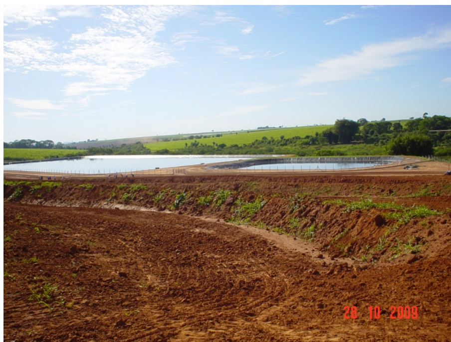
Figura 3. ETE.2 – Lagoas de Estabilização
