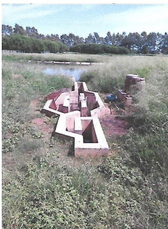
Figura 1 – Vista Geral do Sistema de Tratamento “ETE” – Vila Guarnieri e Nosso Teto, composto pela Calha Parshall, Lagoa Anaeróbia e Lagoa Facultativa.
