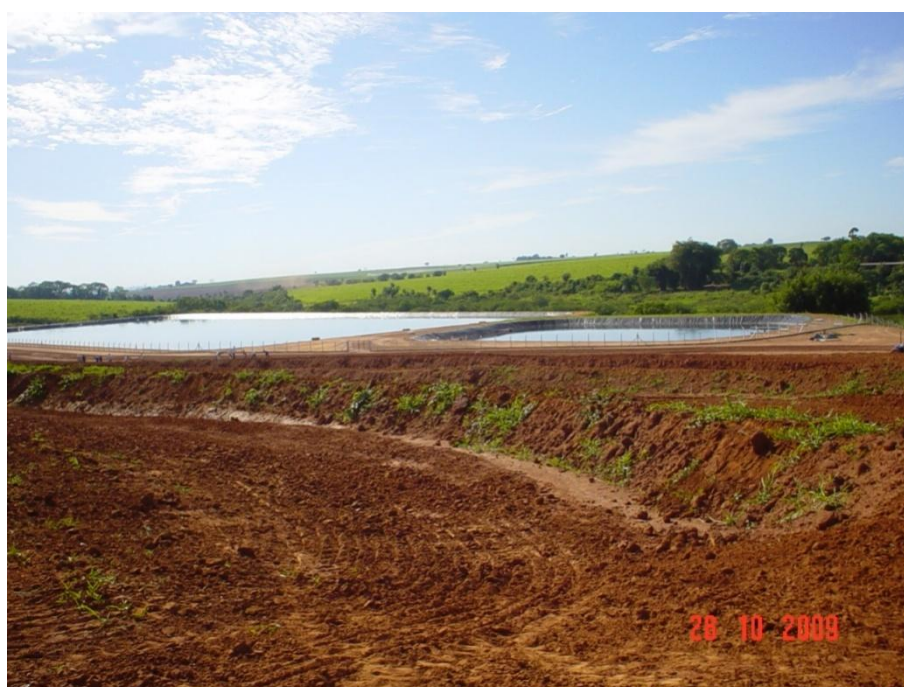
Figura 4. ETE.2 – Lagoas de Estabilização
