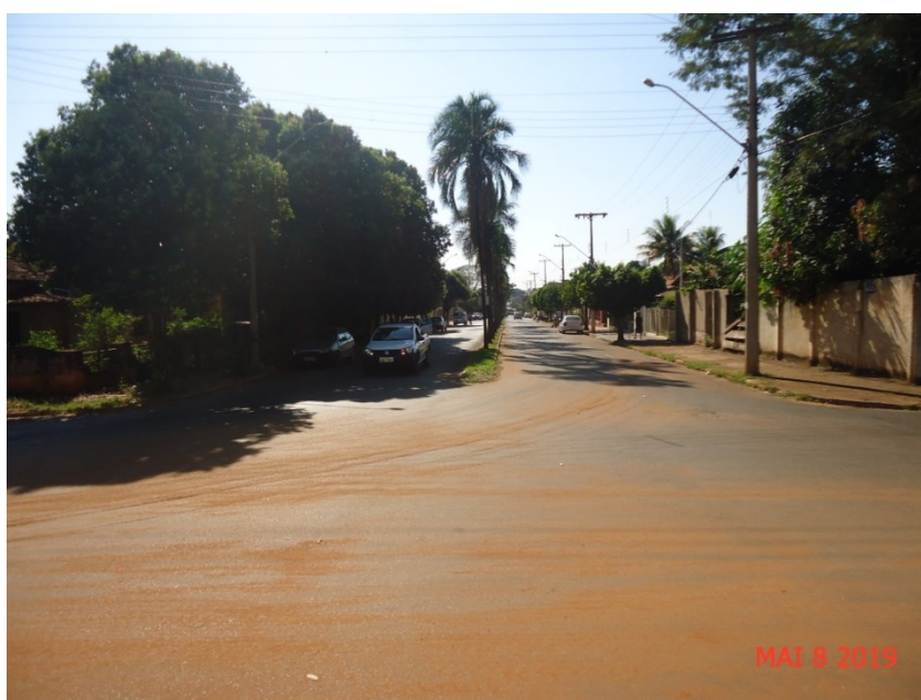
Figura 6 - Vista da Avenida Rui Barbosa, substituição da rede existente de FoFo - "ferro fundido", para rede de abastecimento de água potável de PVC/PBA de Dn 50 mm.
