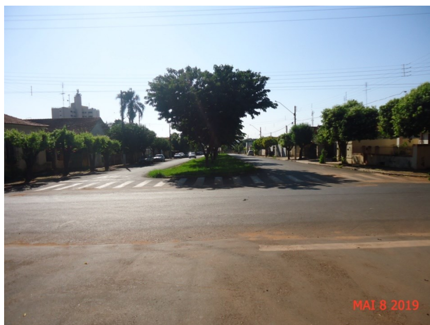
Figura 4 - Vista da Avenida Vereador Pedro Osvaldo Basso, substituição da rede existente de FoFo - “ferro fundido”, para rede de abastecimento de água potável de PVC/PBA de Dn 50 mm.
