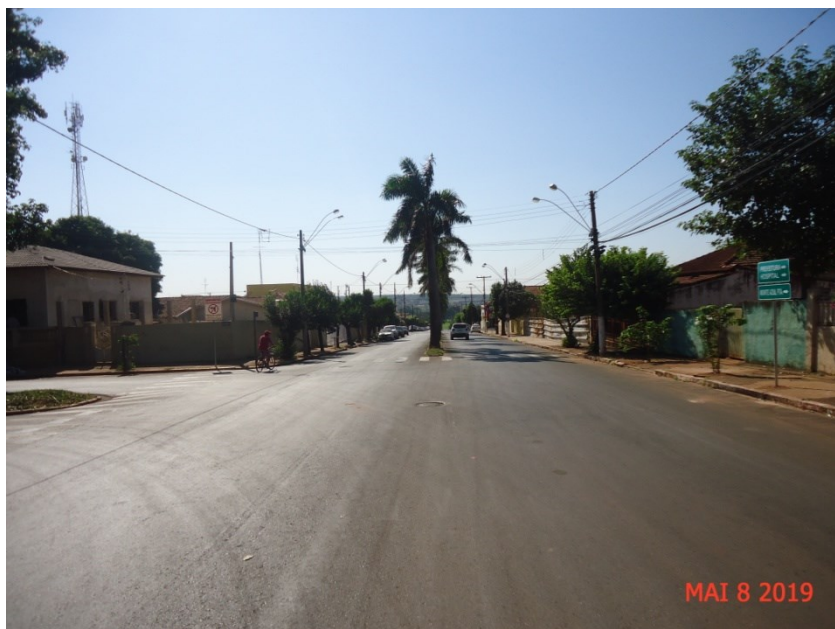
Figura 15 - Vista da Avenida Coronel Antenor Junqueira Franco, substituição da rede existente executada em FoFo - “ferro fundido”, para rede de abastecimento de água potável executada com tubo PVC/PBA de Dn 50 mm.
