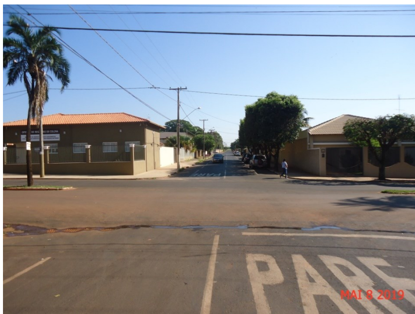
Figura 7 - Vista da Rua José Marques de Oliveira, substituição da rede existente de FoFo - “ferro fundido”, para rede de abastecimento de água potável de PVC/PBA de Dn 50 mm.
