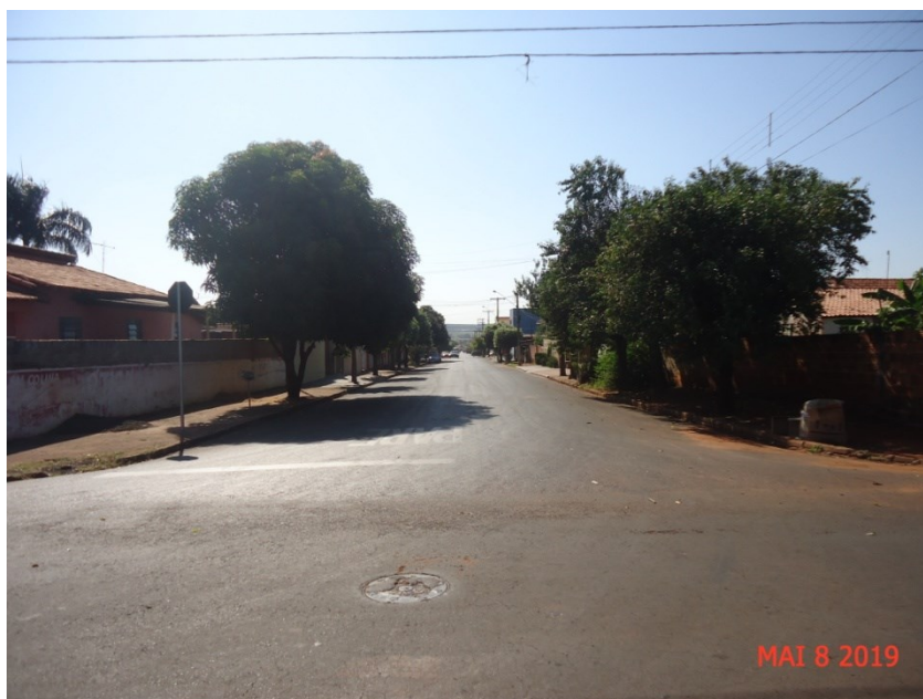
Figura 11 - Vista da Rua Eugênio Donini, substituição da rede existente de FoFo - “ferro fundido”, para rede de abastecimento de água potável de Dn 100 mm executada em PVC/PBA.
