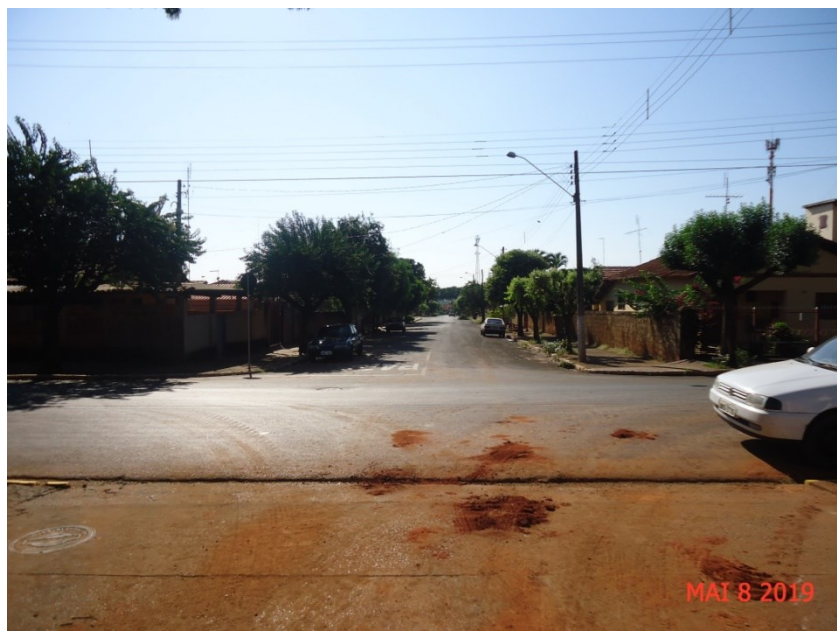
Figura 3 - Vista da Rua Luciano de Mello Nogueira, substituição da rede existente de FoFo - “ferro fundido”, para rede de abastecimento de água potável de PVC/PBA de Dn 50 mm.
