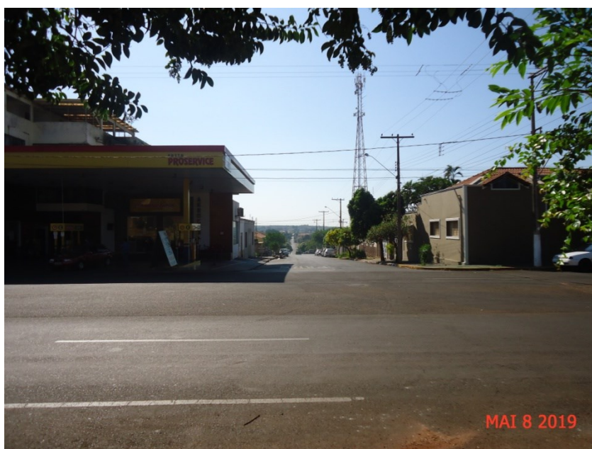
Figura 16 - Vista da Rua Antônio Guarnieri, substituição da rede existente executada em FoFo - “ferro fundido”, para rede de abastecimento de água potável executada com tubo PVC/PBA de Dn 50 mm.
