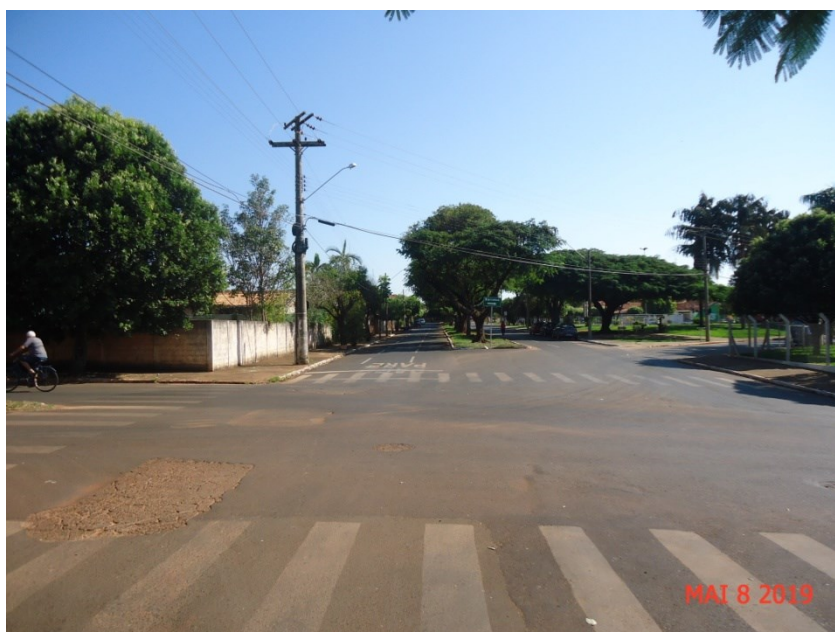
Figura 8 - Vista da Rua Coronel José Venâncio, substituição da rede existente de FoFo - “ferro fundido”, para rede de abastecimento de água potável de PVC/PBA de Dn 50 mm.
